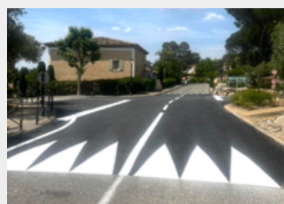
Marquage de la nouvelle plateforme de ralentissement, située rue des Alpilles.
