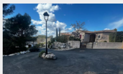
Réfection de l'enrobé des chaussées du quartier La Citadelle 2.
