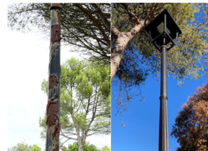
Réfection et mise en peinture des candélabres
