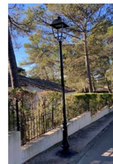
Remplacement d'un candélabre rue des Vallons (suite accident)
