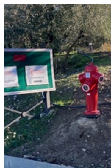
Remplacement d'une borne incendie
