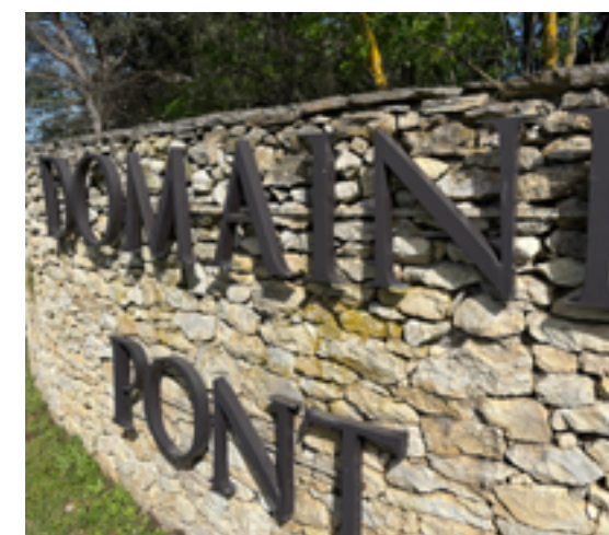
Nettoyage et traitement anti fongique du mur extérieur (rond-point) et du mur du virage rue de Vernègues (bas trou n°1)
