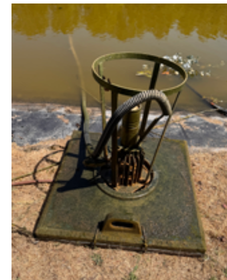
Réparation du jet d'eau au trou n°10
