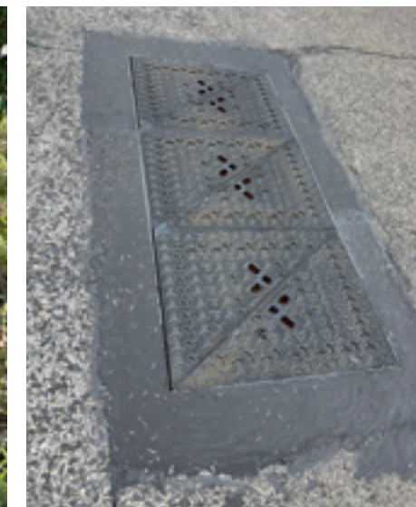
Consolidation des plaques d'égouts
