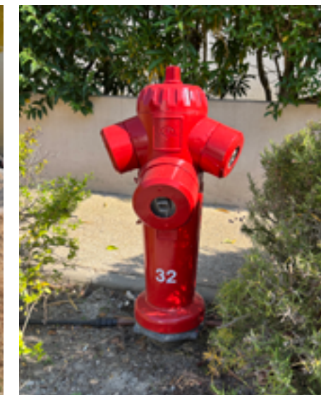
Mise en peinture des bornes à incendie
