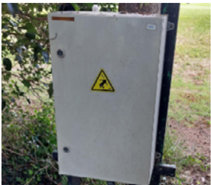
Réparation suite pannes électriques (Rue de Vernègues, Micocouliers)
