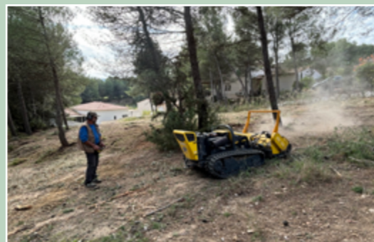
Débroussaillage (OLD), nettoyage des pins et nivellement du sol, sur la parcelle de la ZP6 prévue pour accueillir l'oliveraie.
