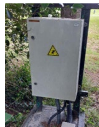
Remplacement armoire électrique (câbles endommagés par rongeurs)
