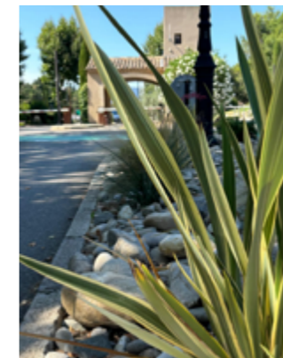
Changement de spots défectueux en LED (dans les massifs)
