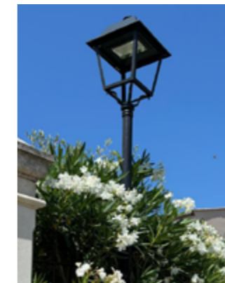
Mise en sécurité d'éclairages accidentés au poste de garde.
