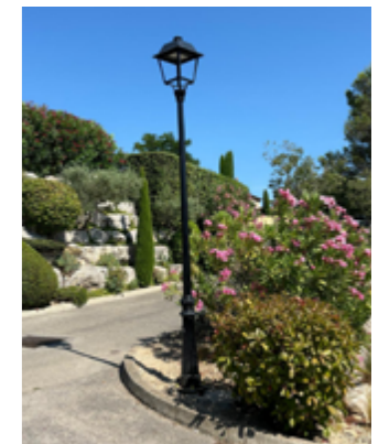
Installation d'un lampadaire à Citadelle 2
